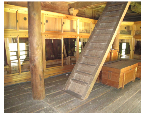
こうじまえちゆうそうないぶ 工事前の中倉内部
