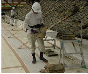
瓦を1枚ずつ取り外し確認の様子
